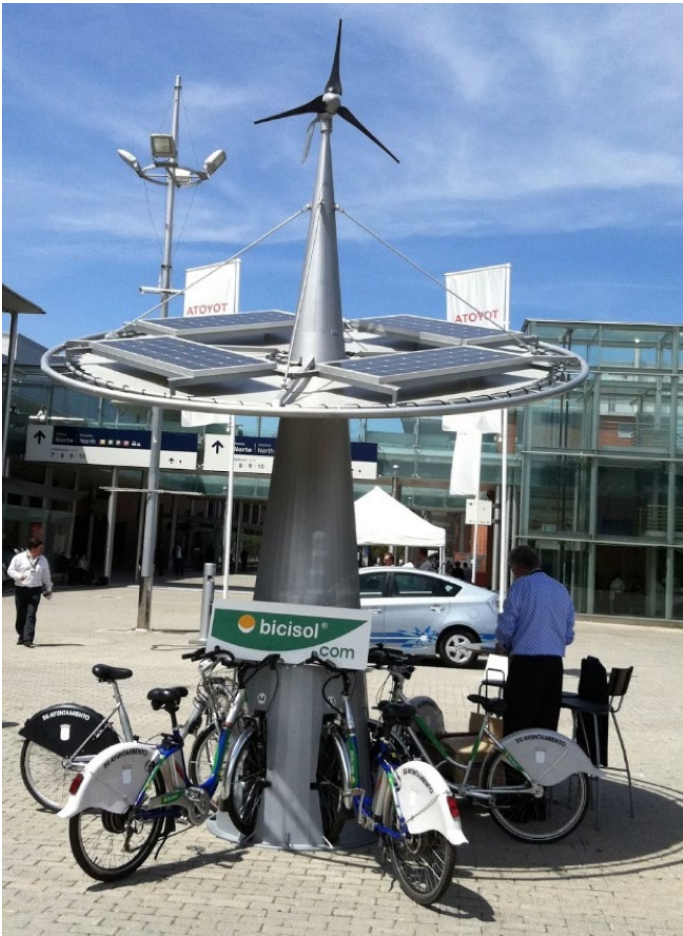
Estación de Bicicletas Compartidas Eléctricas con recarga mediante energía solar y eólica
